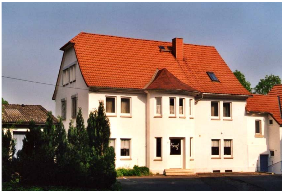
Tagesgruppe 3 im Hauptgelände der Leppermühle
